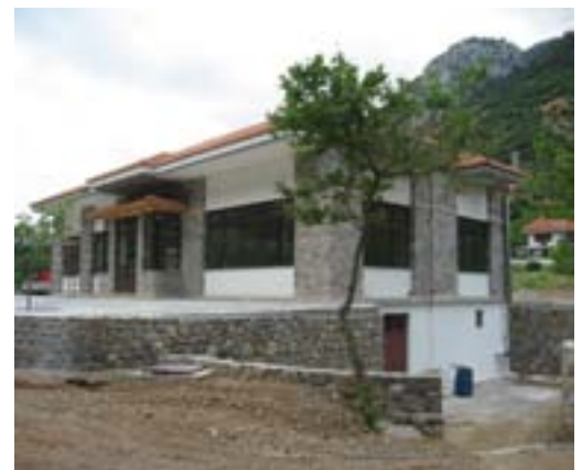
Bild 9: Griechenland – Bau und Ausstattung einer Taverne
